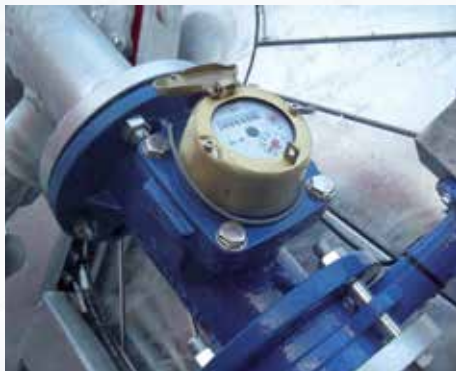
Auf den Spuleneintritt geflanschter Literzähler:
