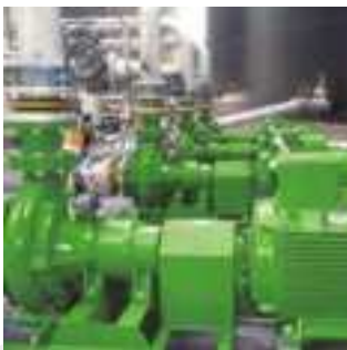
MAGNUM SX Dickstoffpumpe Getriebe- und Lagerstuhlausführung
